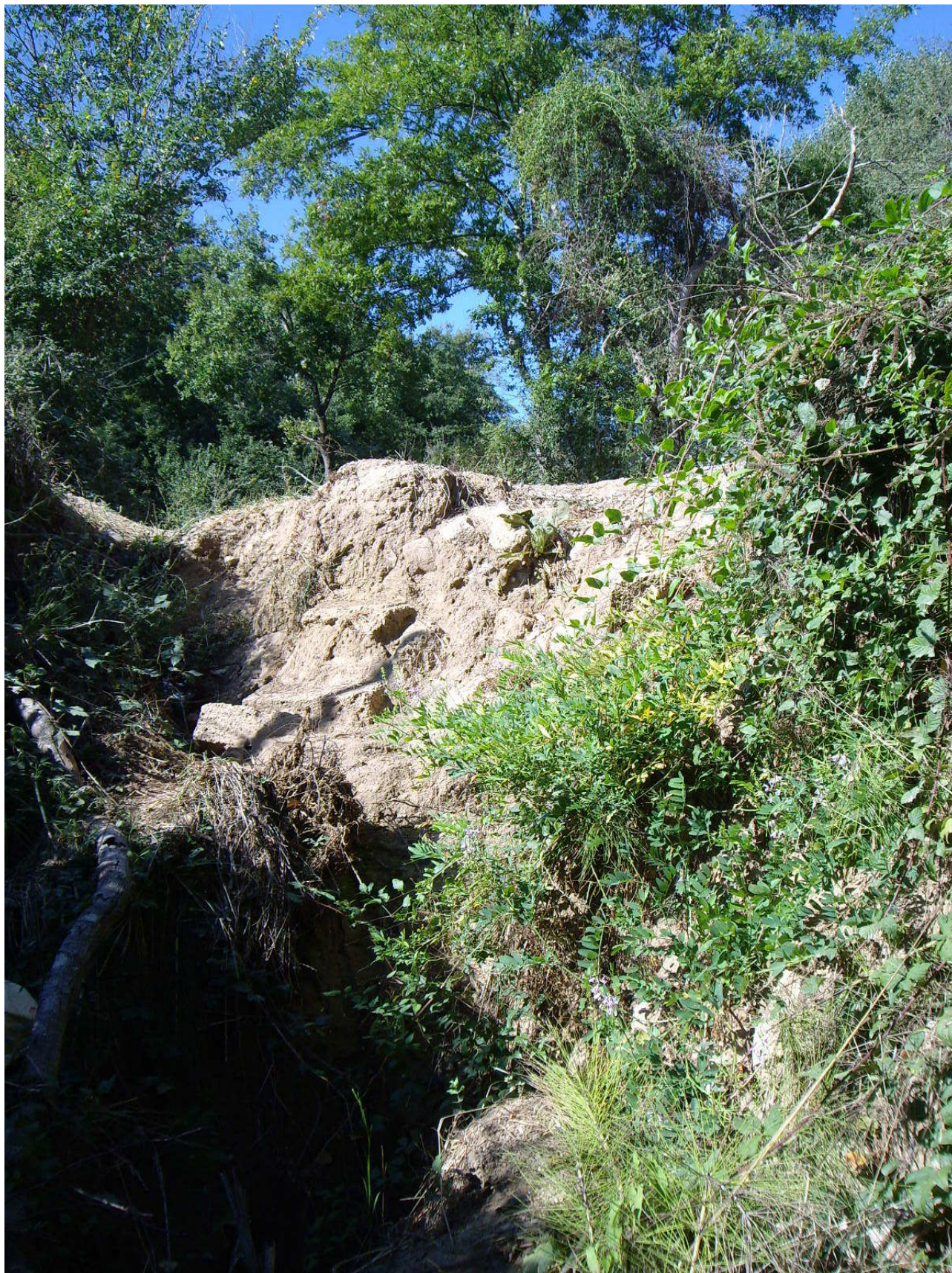
Foto n. 12 – Smottamento del ciglio della vicinale vista da fosso sottostante, realizzazione di gabbionata di contenimento e canaletta in legname e pietrame per il deflusso delle acque
