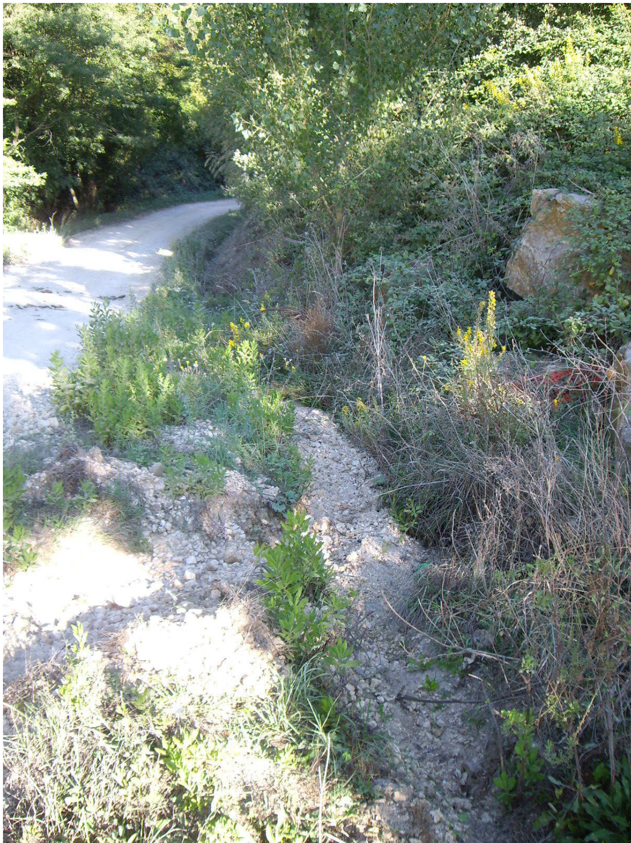
Foto n. 25 – Versante di monte dove posizionare la gabbionata e realizzazione di canaletta per la regimazione delle acque
