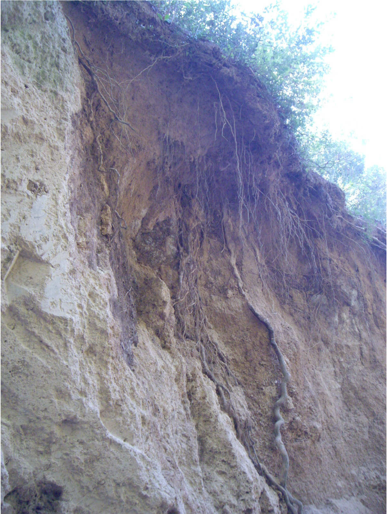
Foto n. 8- Altro particolare del versante e ciglio superiore instabile
