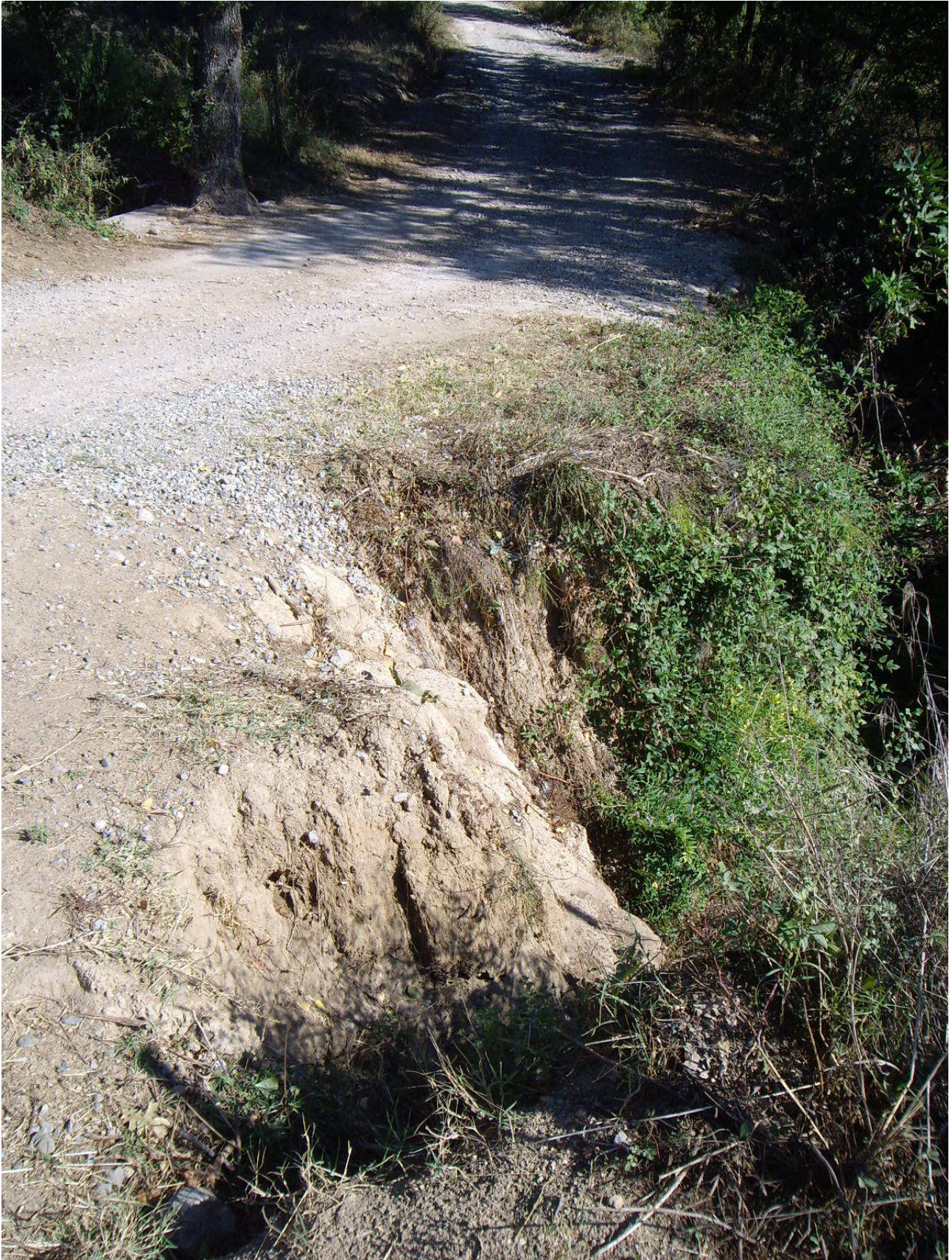
Foto n. 11 – primo smottamento – realizzazione di gabbionata
