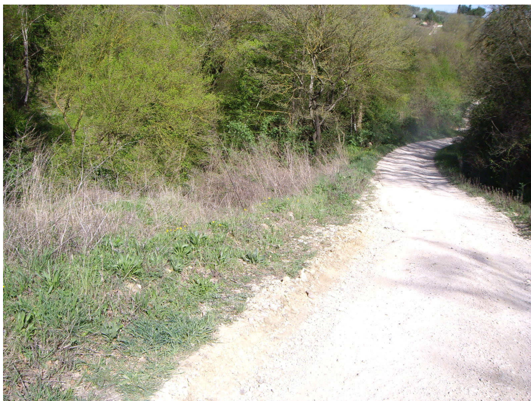
Foto n. 21 – realizzazione a valle di gabbionate a completamento di quelle esistenti e fosso di guardia per la regimazione delle acque
