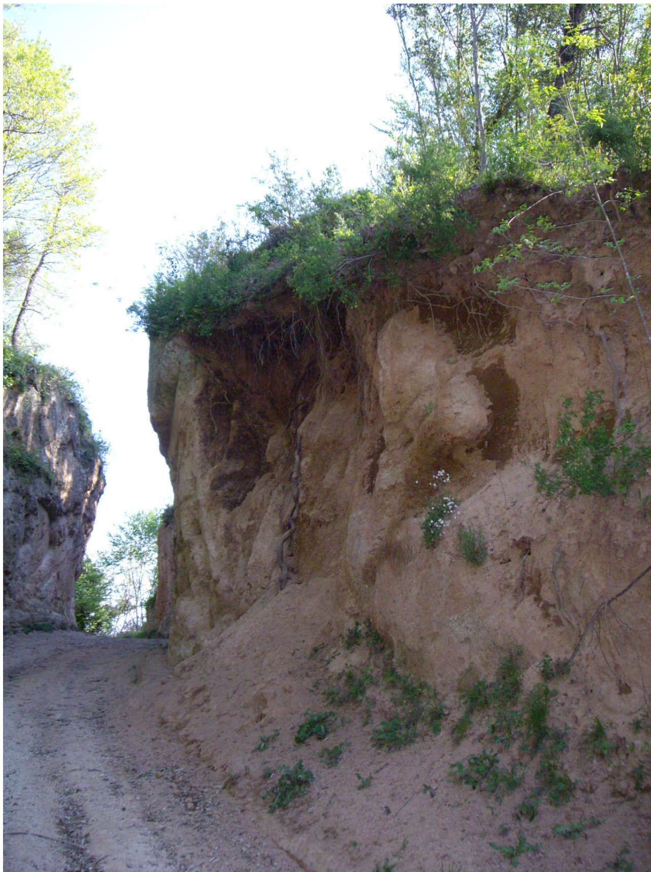
Foto n. 4 – Smottamento della parete con ciglio instabile e accumulo di materiale
