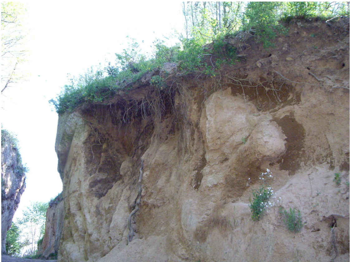
Foto n. 6 – Particolare del ciglio sopra strada
