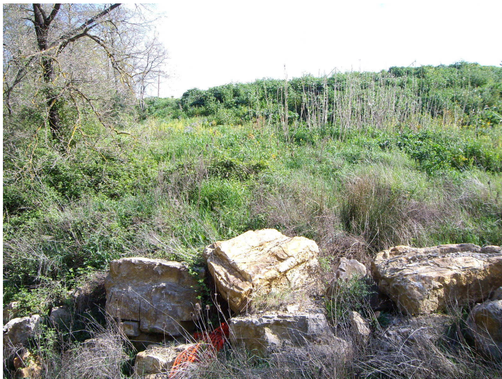
Foto n. 20 – Versante superiore instabile dove realizzare i drenaggi e la gabbionata di contenimento alla base
