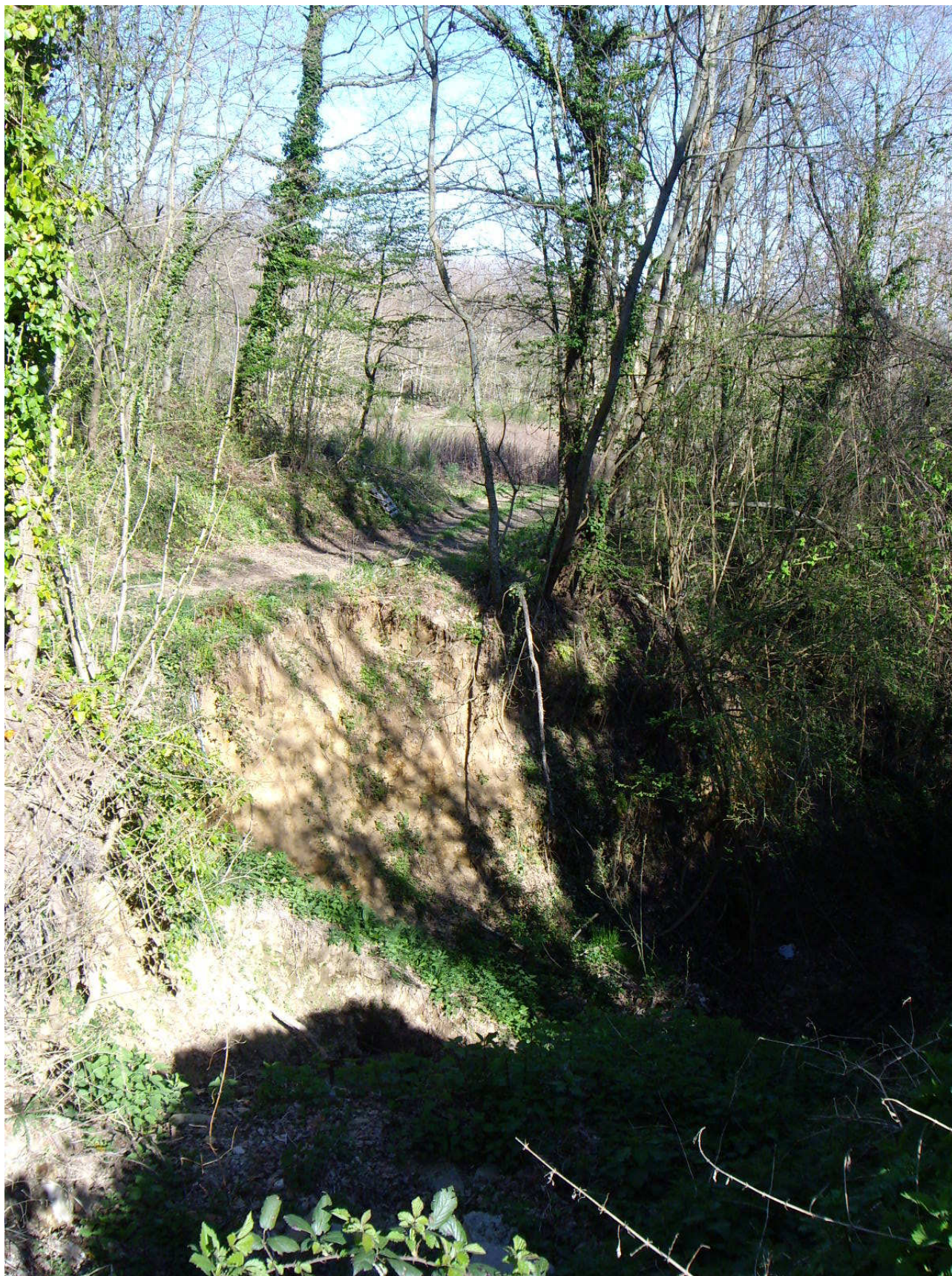
Foto n. 15 – frana del versante di valle della pista forestale
