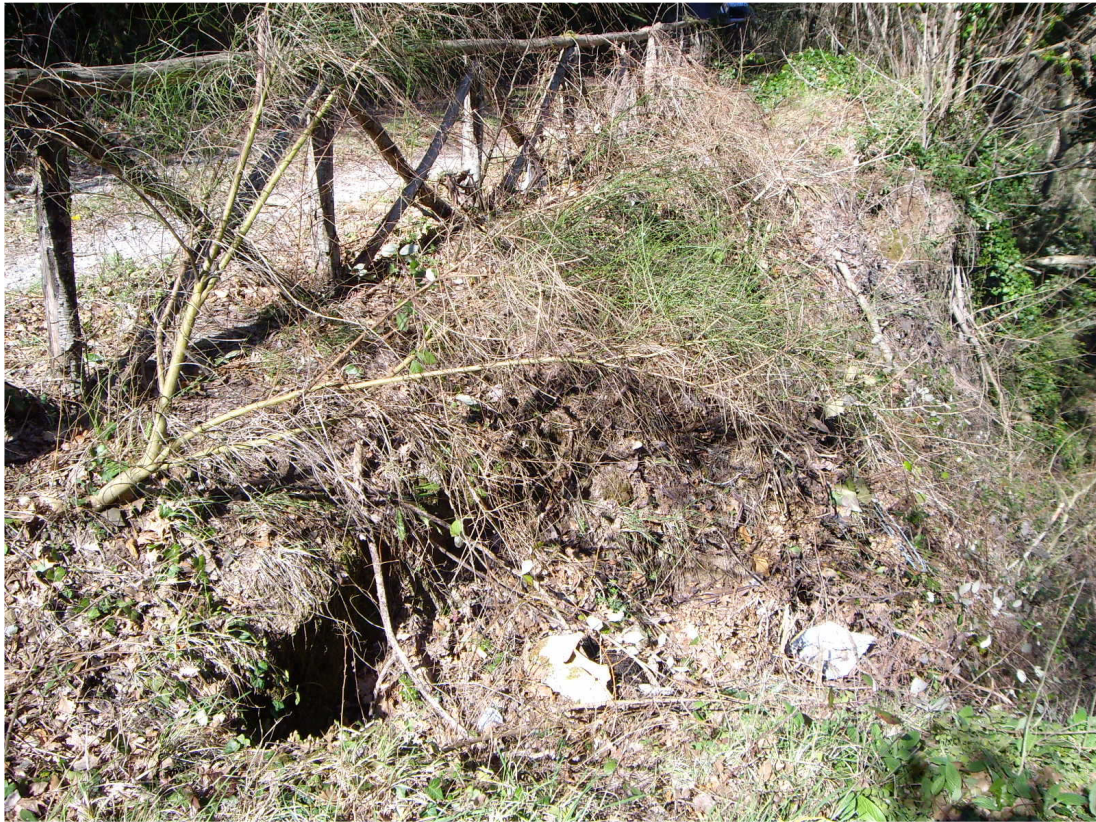
foto n. 3 – Altro particolare del fenomeno
