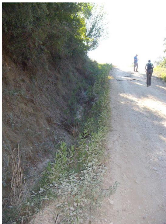
Foto n. 23 – realizzazione a monte strada di canaletta per la regimazione delle acque
