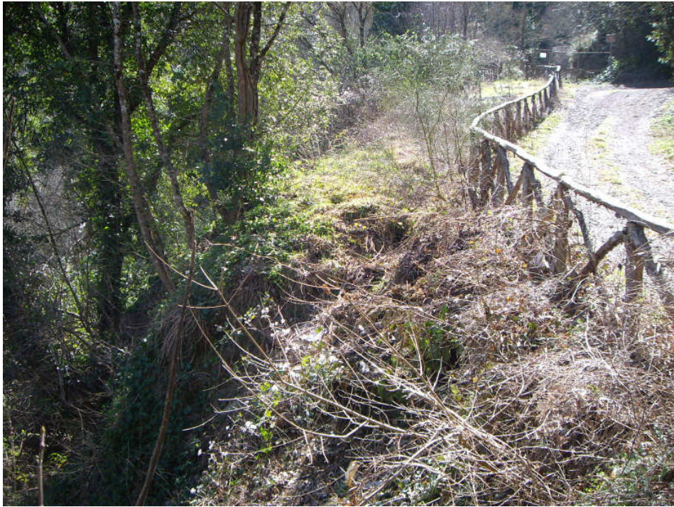
Foto n. 1 – smottamento a valle – realizzazione di gabbionate e ripristino staccionata di protezione
