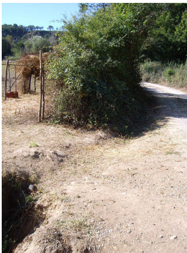
Foto n. 14 – ripristino a monte del fenomeno di canaletta per la regimazione delle acque meteoriche della vicinale
