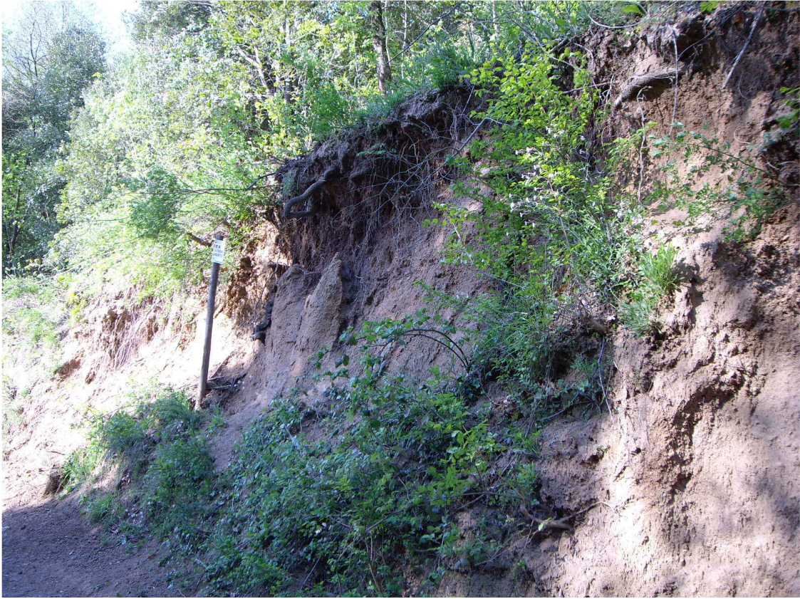
Foot n. 5 – situazione lato opposto
