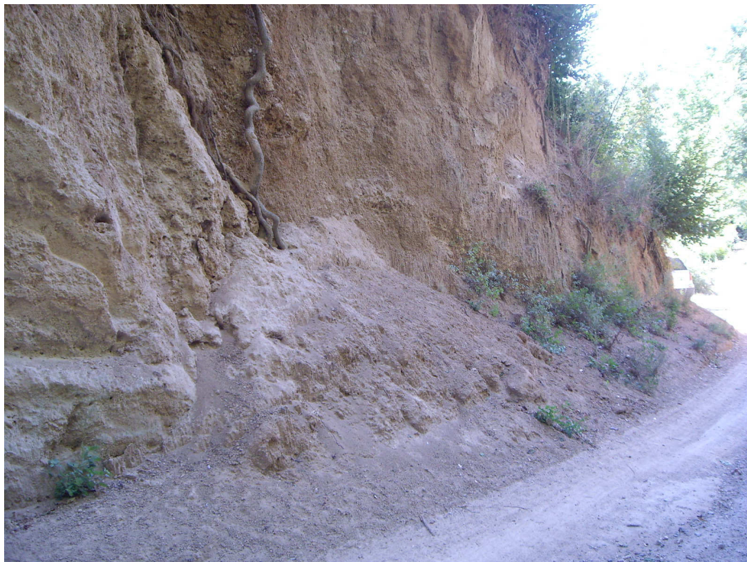
Foto n. 9 – Particolare dell'accumulo di detrito
