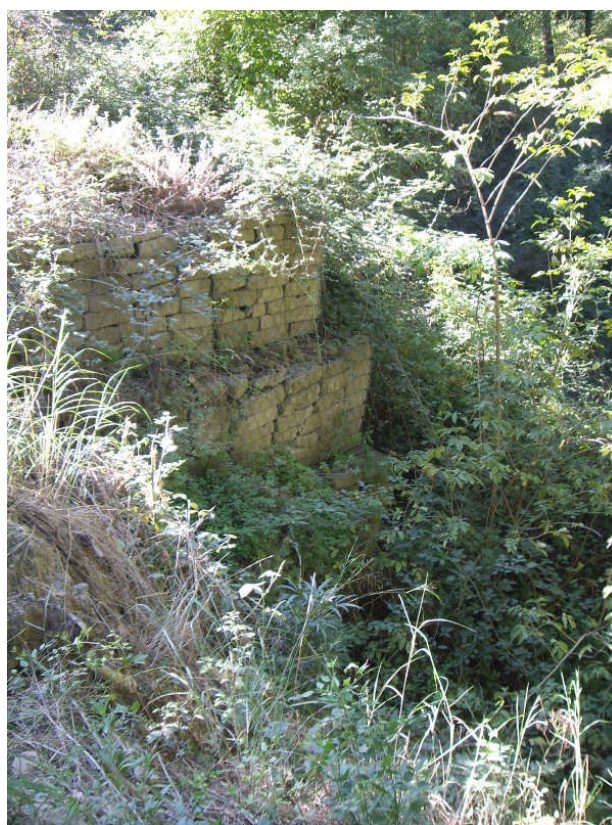
Foto n. 22 – Gabbionate del vecchio intervento da proseguire
