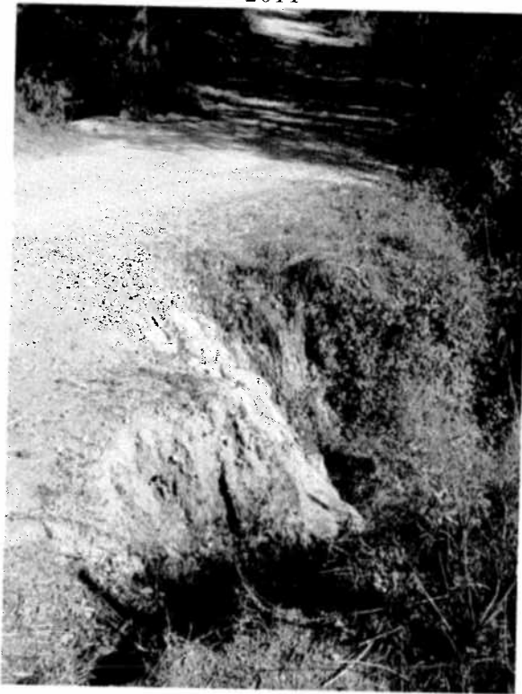
realizzazione di gabbionata
