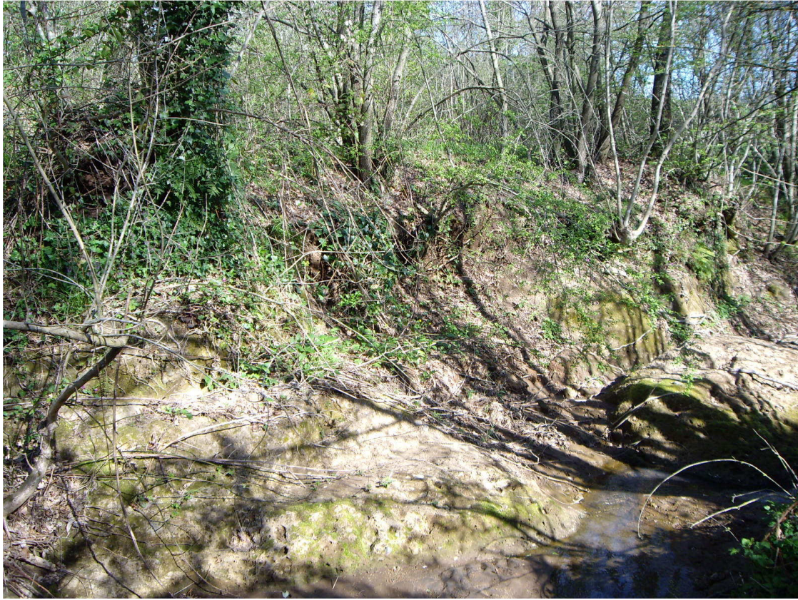
foto n. 17 – comune di Sorano – Poggio Bortolo – erosione di sponda, realizzazione di piccole scogliere e palizzate in legname
