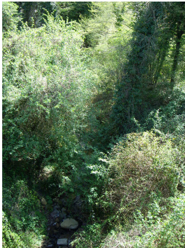
foto n. 6 – comune di Scansano – fosso Fonte Vecchia – vegetazione e piante in alveo
