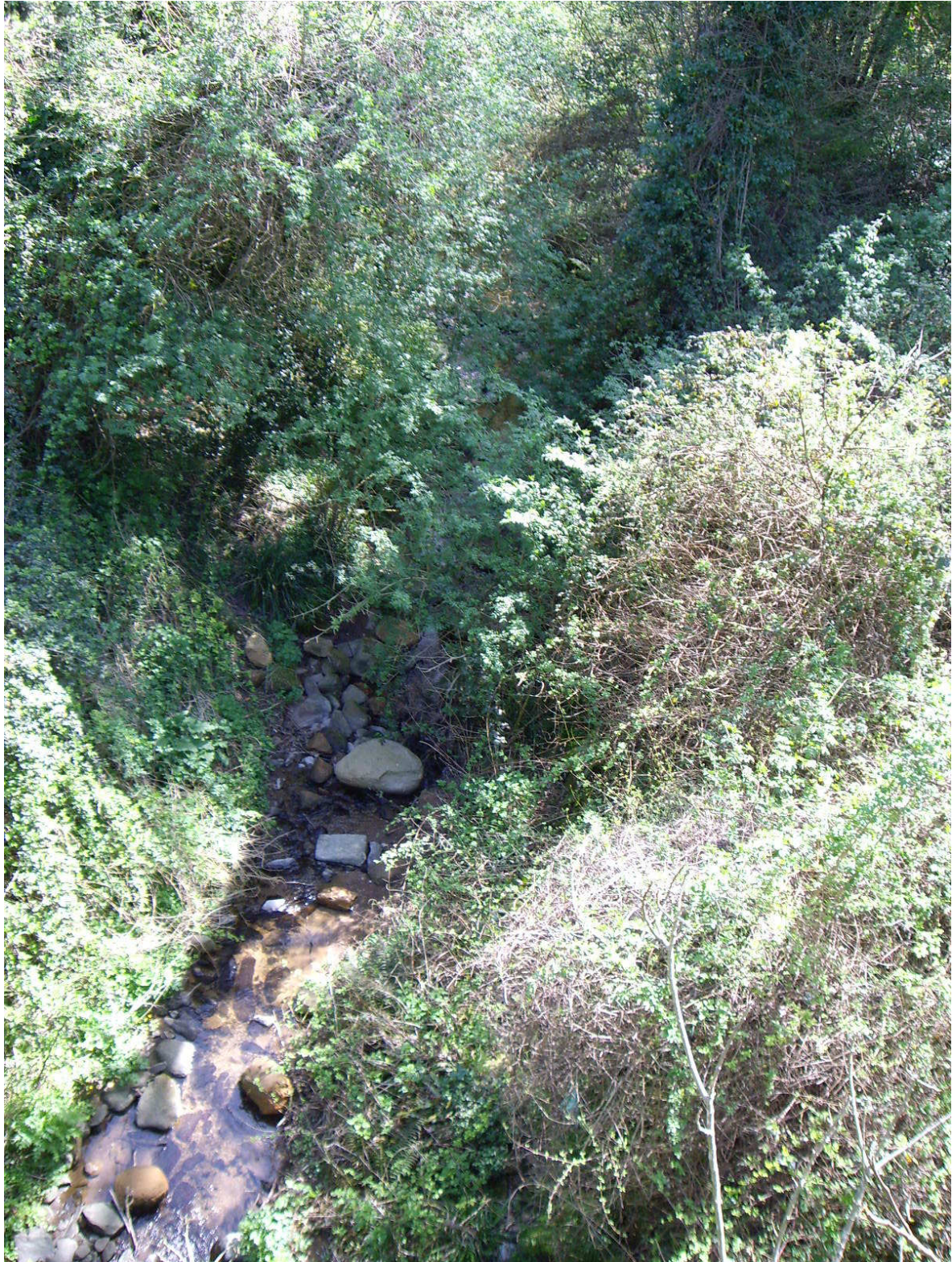
foto n. 7 – comune di Scansano – fosso Fonte Vecchia – presenza di piante nella sezione idraulica
