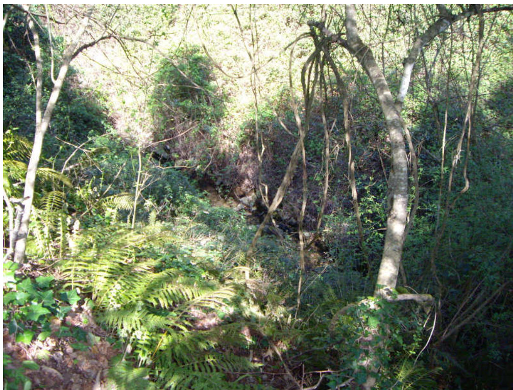
foto n. 3 – comune di Scansano – fosso dei Mulini- presenza di piante in alveo e piccoli smottamenti in sponda sx
