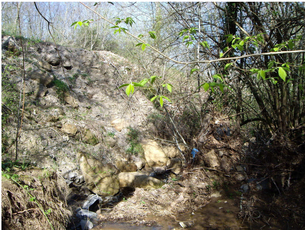
foto n. 13 – comune di Sorano – Poggio Bortolo – sponde in erosione realizzazione di piccole scogliere e taglio piante in alveo
