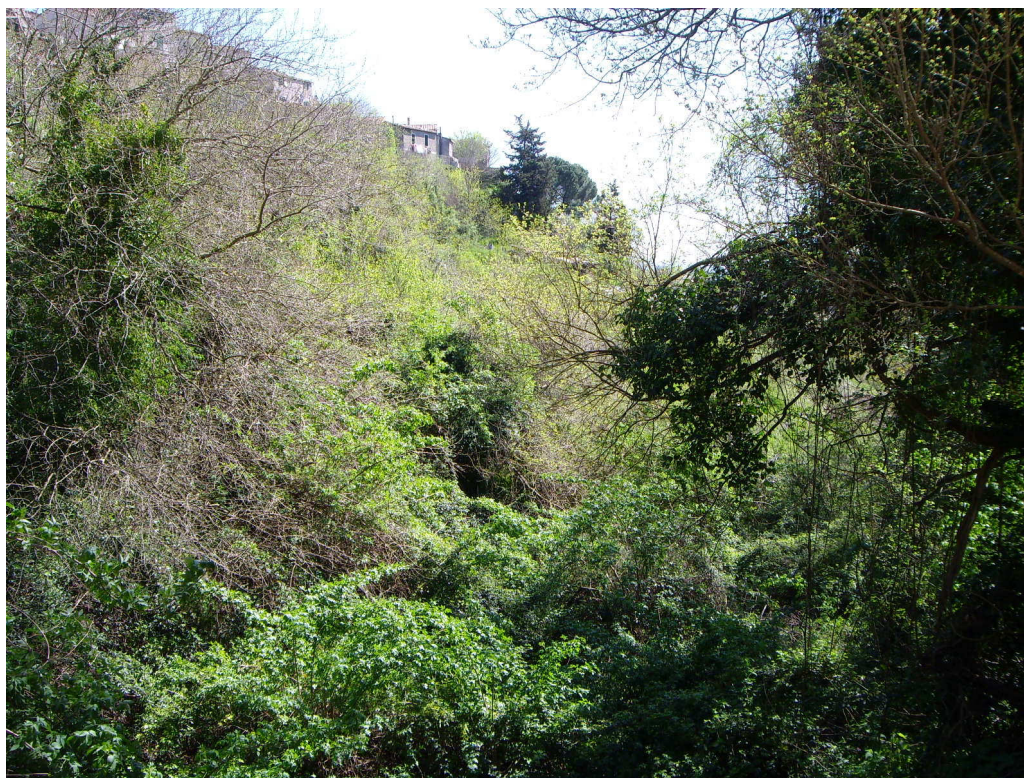
foto n. 4 – comune di Scansano – fosso Fonte Vecchia – parte iniziale sotto l'abitato completamente ostruita dalla vegetazione
